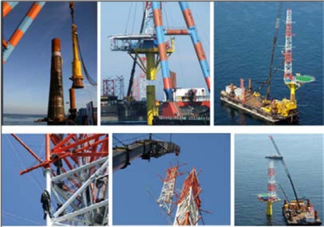
Şekil 6. FINO 3 inşaatına ait fotolar.
