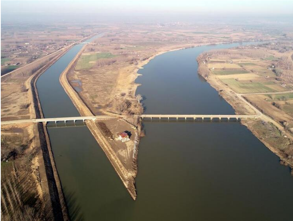
Şekil 7 Meriç nehri üzerinde yapılan tahliye kanalının (Kanal Edirne) havadan görünümü, (Fotoğraf, 18 Şubat 2019 tarihli Hürriyet Gazetesinden alınmıştır)
