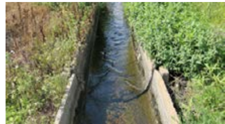
Kanal ve kanalet tipi iletim hatlarından kesitler
