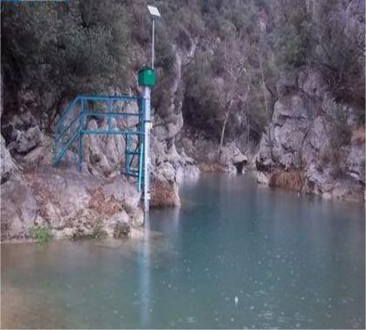
Resim 1 Akım Gözlem İstasyonu (AGİ)(DSİ Arşivi)
