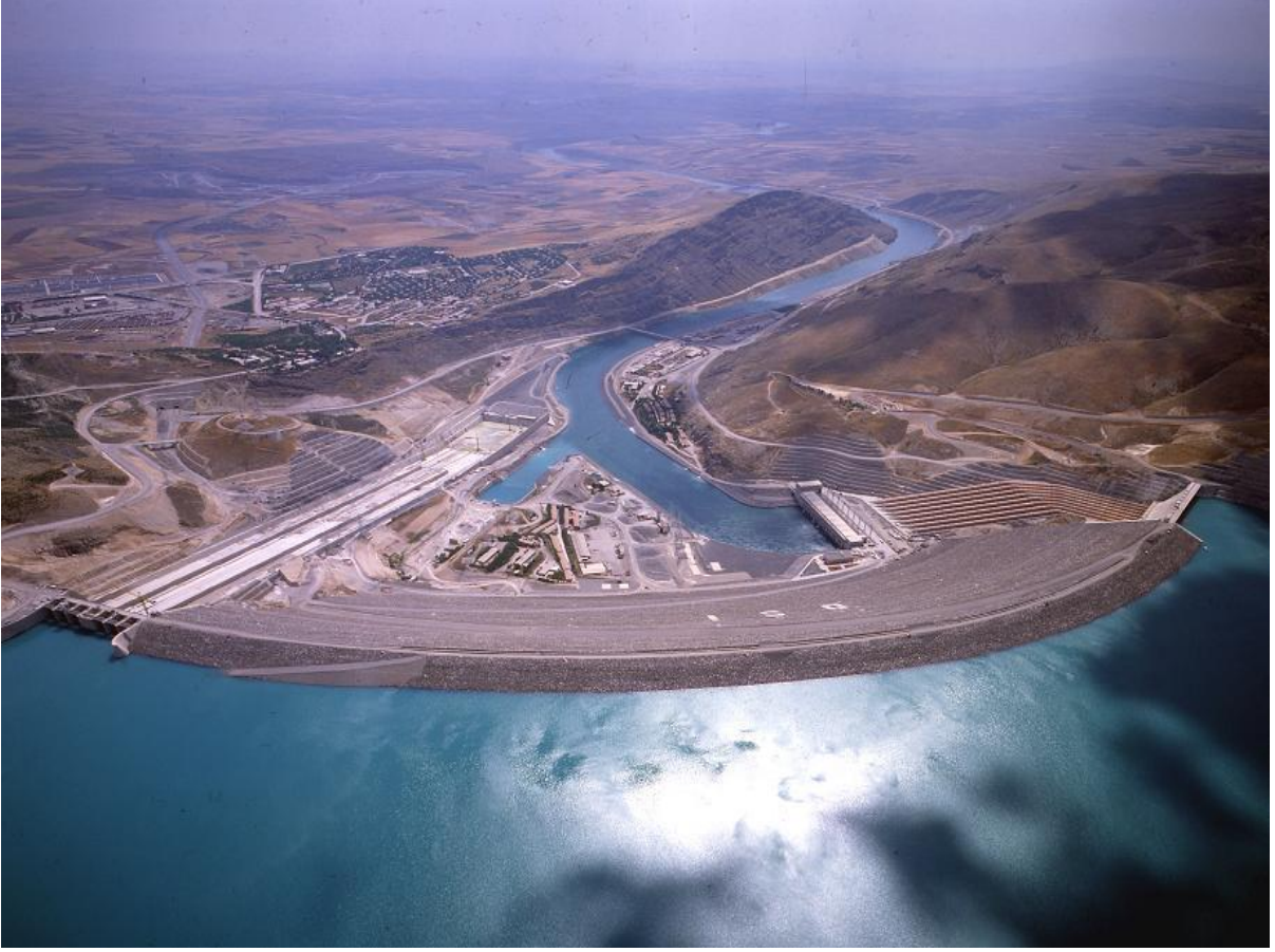
Resim 1 Atatürk Barajı Bozova/ŞANLIURFA
