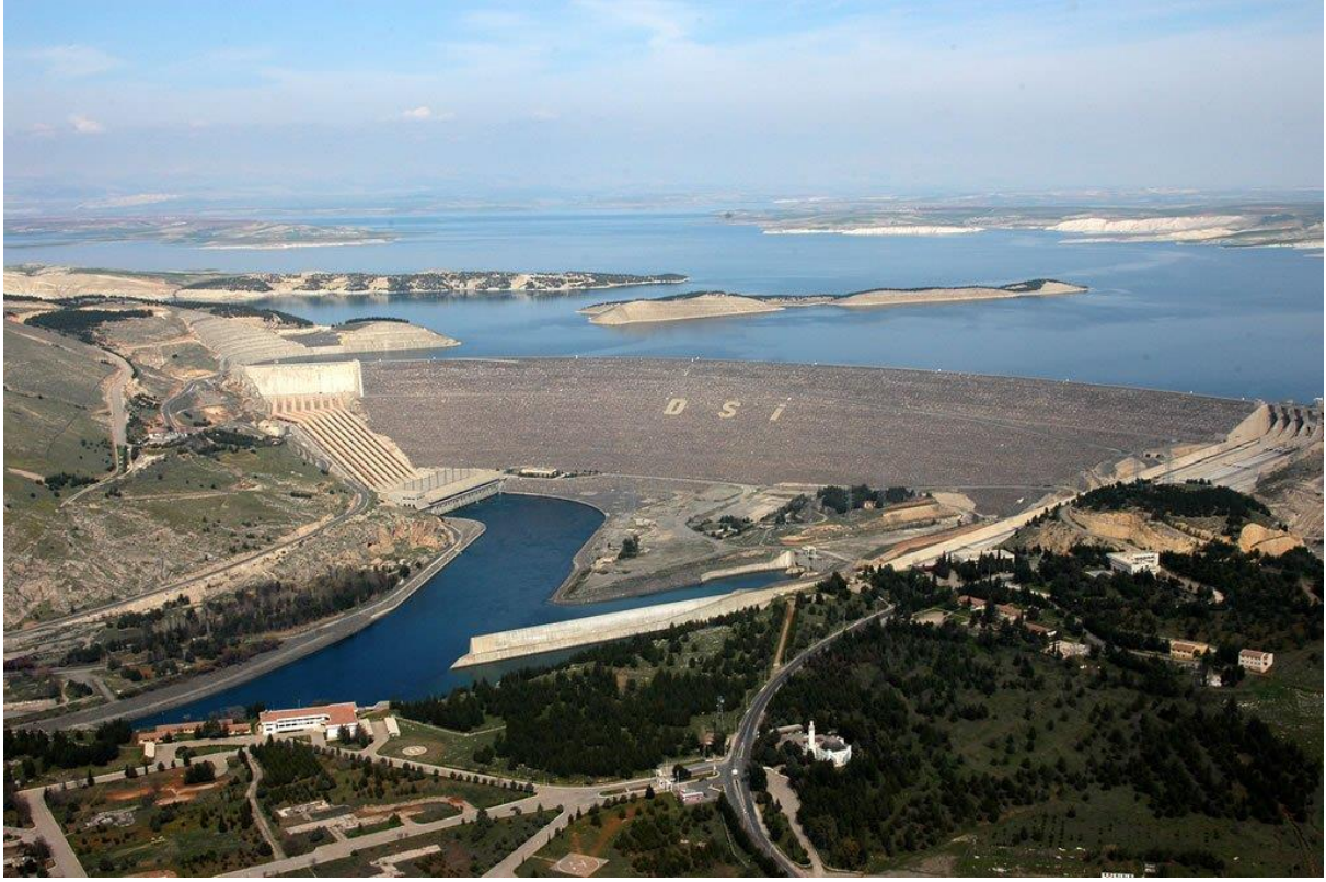
Resim 4 Atatürk Barajı, Bozova/ŞANLIURFA
